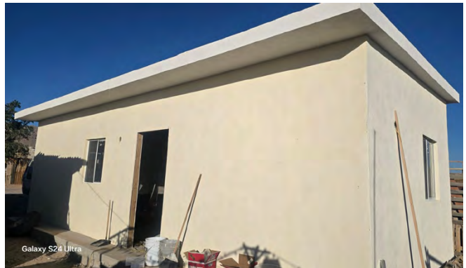
Avance de la casa en construcción.
