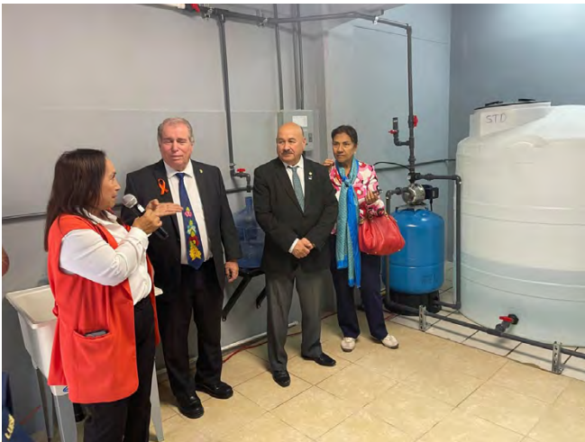
Club Rotario Tijuana Oeste / Donaron e instalaron una planta purificadora de agua al Instituto Tecnológico de Tijuana (ITT) en Baja California / Con capacidad de cuatro mil litros por día, esta planta se otorgó con el apoyo de la empresa CONAMI para mejorar el acceso al agua segura dentro del instituto, donde se beneficiarán cinco mil alumnos, así como personal docente y administrativo; de esta manera se reducirá considerablemente el uso de botellas desechables / La planta con valor de 8 mil 950 pesos trabaja por ósmosis inversa con sistemas de filtración, bombeo, UV y tomas de llenado / Líderes rotarios y académicos fueron testigos del proyecto sustentable en beneficio directo de la infraestructura académica.
