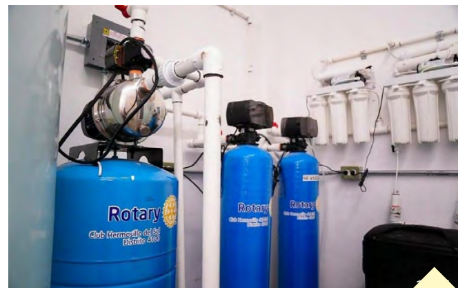
Club Rotario Hermosillo del Sol / Donaron e instalaron una planta purificadora de agua (incluye tanques, filtros y equipo de ósmosis) para beneficiar a más de mil alumnos de dos primarias: Rafael Santacruz Reyes y Pedro Fructuoso Padilla Méndez / El objetivo es brindar acceso al agua segura, limpia y de calidad a través de nuevos dispensadores de agua purificada para el consumo diario, fortaleciendo así la salud y el bienestar de la comunidad escolar en Hermosillo, Sonora.
