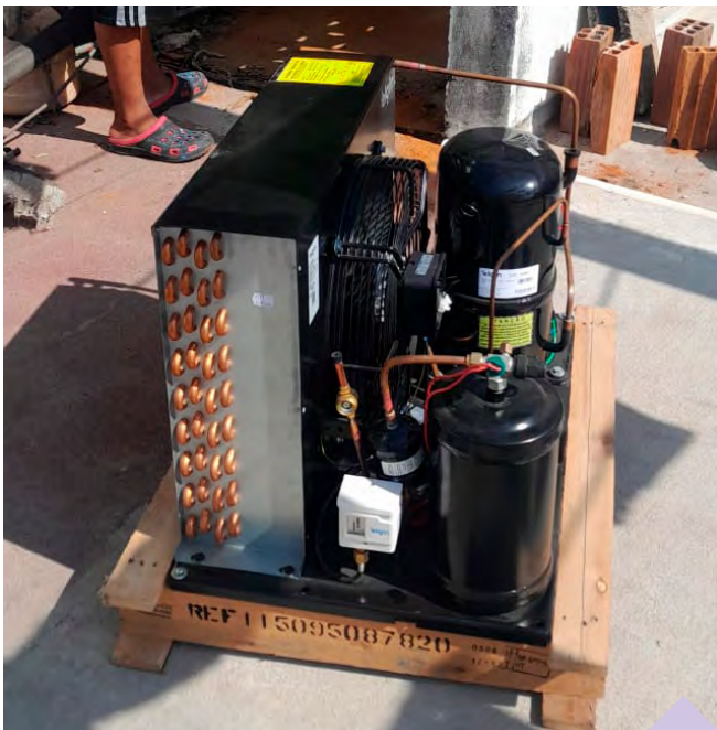
Club Rotario Acapulco Icacos / Repararon la cámara frigorífica y su instalación eléctrica en la “Casa Mash” ubicada en Olaya Bonfil, Acapulco, Guerrero, ya que después del paso del huracán Otis quedó muy dañada; los alimentos constantemente se caducaban / Recaudaron fondos organizando una noche de casino, a fin de comprar equipo nuevo para sustituir el dañado; también se cambió la chapa de la puerta y se le dio mantenimiento a los equipos de aire acondicionado de la casa / El club continúa el proyecto en una segunda fase para poder cambiar el cableado dañado desde el poste de la calle, esto con el apoyo de la Comisión Federal de Electricidad.
