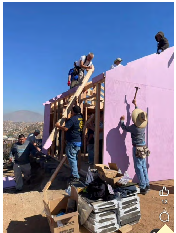
Club Rotario Tecate / Jornada de colaboración para construcción y labor escolar / Al mejorar la infraestructura, mejoran las actividades escolares, beneficiando directamente a la comunidad de la escuela primaria Club Rotario No. 4 / Rotarios de Santa Cruz, California, se unieron a la construcción de la estructura de madera de la vista principal, fortaleciendo el compañerismo y la amistad rotaria.
