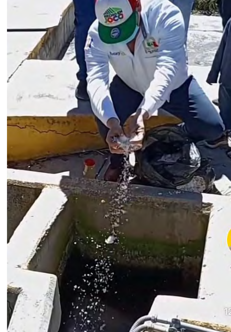
Primera fase donde se agrega cascarón de huevo en la planta de tratamiento.
