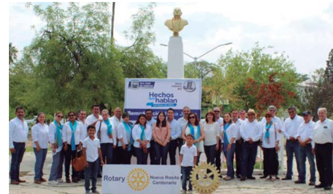
Con ayuda de habitantes de la colonia Roma en Nueva Rosita, Coahuila, el Club Rotario Nueva Rosita Centenario, realizó labores de remodelación en la Plaza Juárez, que incluyó cambio de luminarias e instalación de bancas y aparatos de ejercicio.
