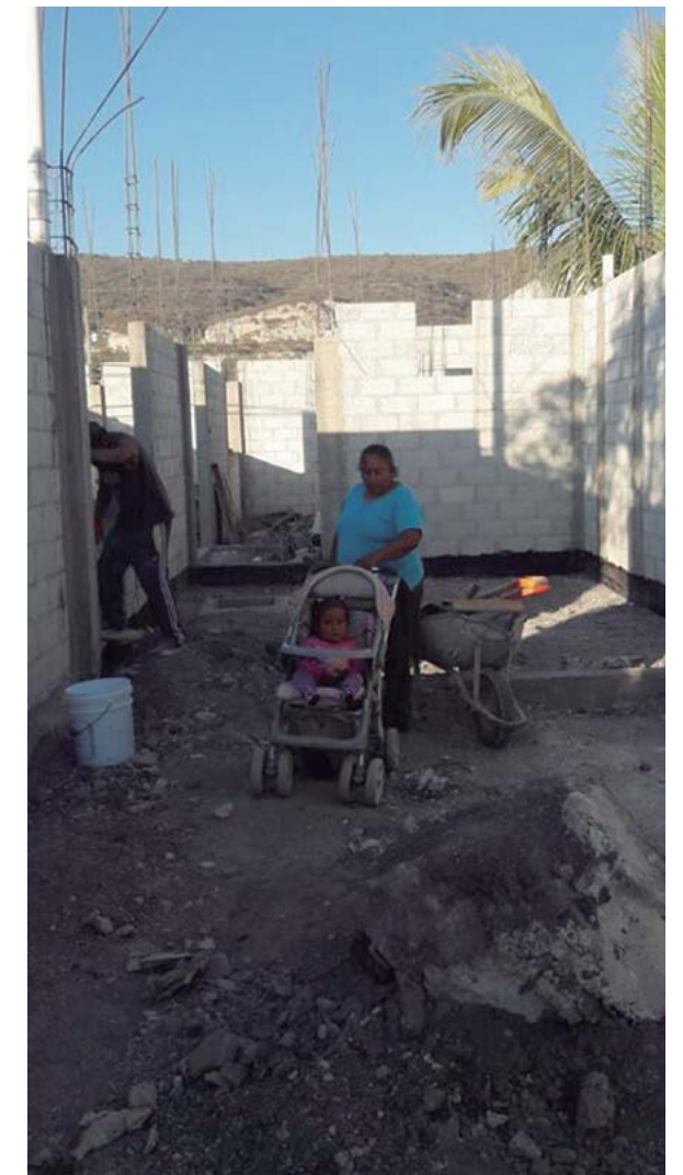
Los Clubes Rotarios Teziutlán y Cholula Milenaria en alianza con el Club de Izúcar de Matamoros , unieron esfuerzos para apoyar a una familia de escasos recursos con deseos de construir su casa que perdieron el pasado sismo del 19 de septiembre en Puebla. Con materiales y supervisión de la obra estos clubes hacen la diferencia.
