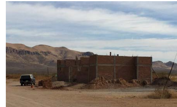
Avances de la construcción del Centro de Atención a la Salud que hace el Club Rotario Chihuahua Majalca , en la colonia ladrillera norte de la Ciudad de Chihuahua.
