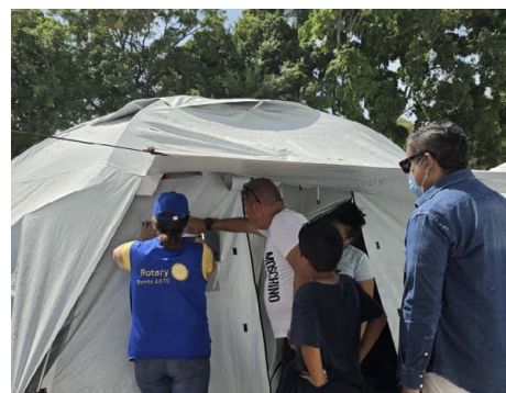
Instalación de módulos de refugio temporal para brindar un espacio seguro a las familias que perdieron su patrimonio habitacional.
