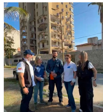
Equipo del Distrito 4380 y rescatares evalúan los daños en estructuras residenciales de Morón, estado Carabobo.
